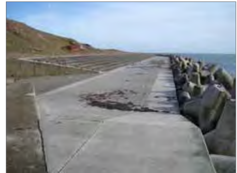
Abb. 73: Uferschutzbauwerk am „Kringel“ (eigene Aufnahme)
