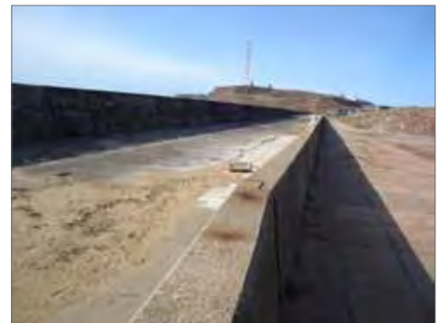
Abb. 74: Wellensturzbecken mit Abfluss in den Vorhafen (eigene Aufnahme)
