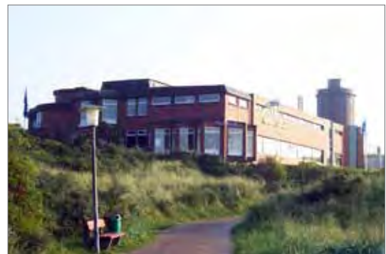
Abb. 77: Meerwasser-Erlebnisbad der Insel Juist, beheizt mit Solarabsorber und Wärmepumpe ( www.erdwaermezeitung.de )
