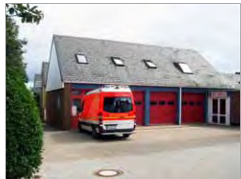
Abb. 20: Feuerwache im Unterland (eigene Aufnahme)
