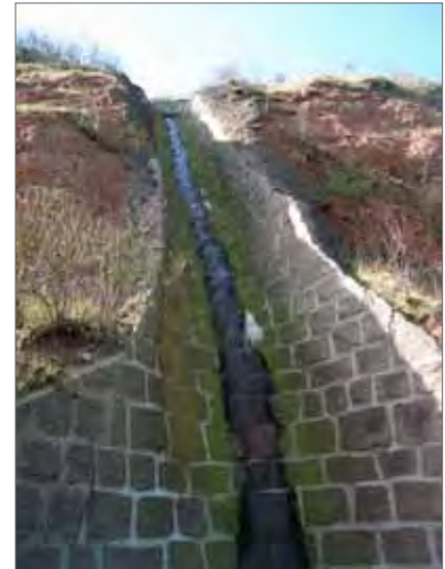
Abb. 72: Kanal für den Abfluss von Niederschlagswasser in das Unterland (eigene Aufnahme)
