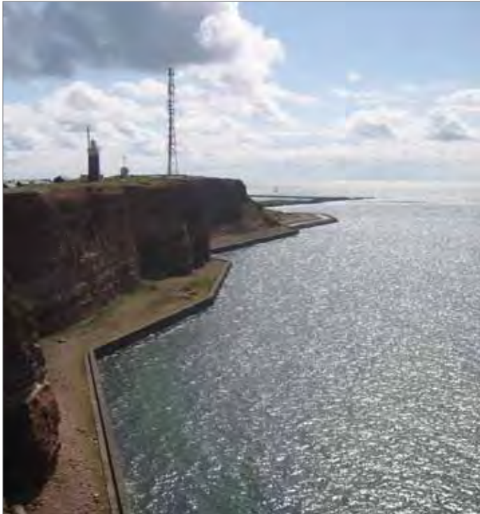
Abb. 105: Süd-West-Schutzmauer (Quelle: Clausen 2009)
