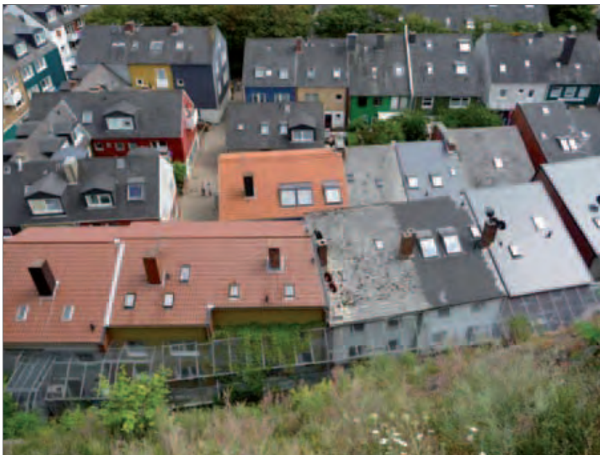
Abb. 49: Dachlandschaft des Unterlandes mit Gauben und Dachflächenfenstern (eigene Aufnahme: 2009)
