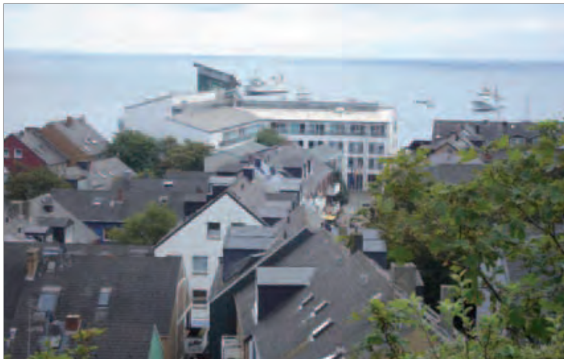
Abb. 48: Hotel Atoll (eigene Aufnahme: 2009)
