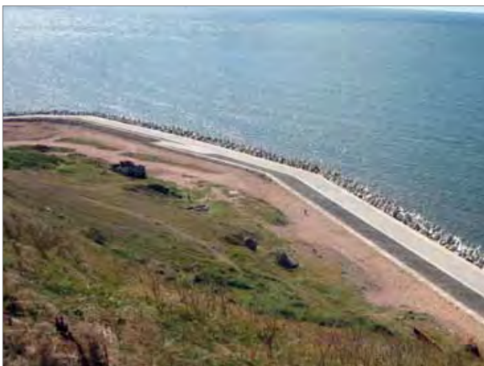
Abb. 108: Grundsanierte Schutzbauwerke am Kringel (eigene Aufnahme: 2009)
