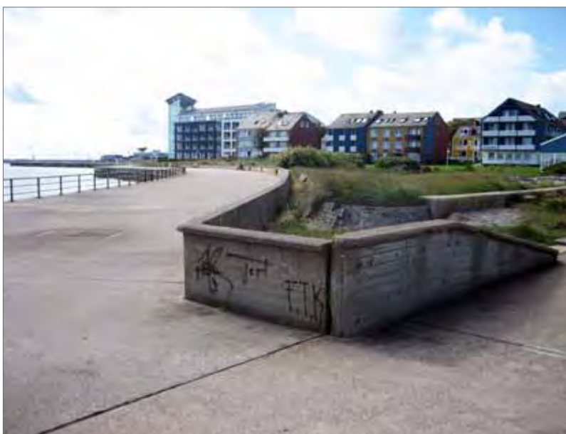
Abb. 109: Nordstrand-Bohlwerk mit Hochwasserschutzwand. Im Hintergrund die Landungsbrücke (eigene Aufnahme: 2009)
