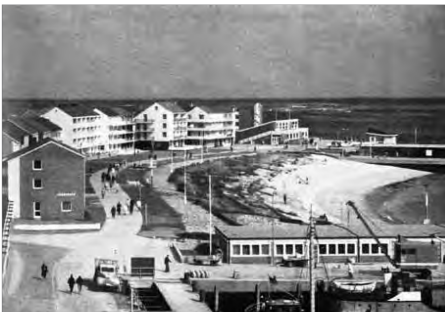
Abb. 37: Häuser am Südstrand, Blickrichtung Norden, vorne links Hotel Insulaner, am Rand hinten rechts das alte Kurhaus gegen Ende der 1950er Jahre (Rickmers: 1986)
