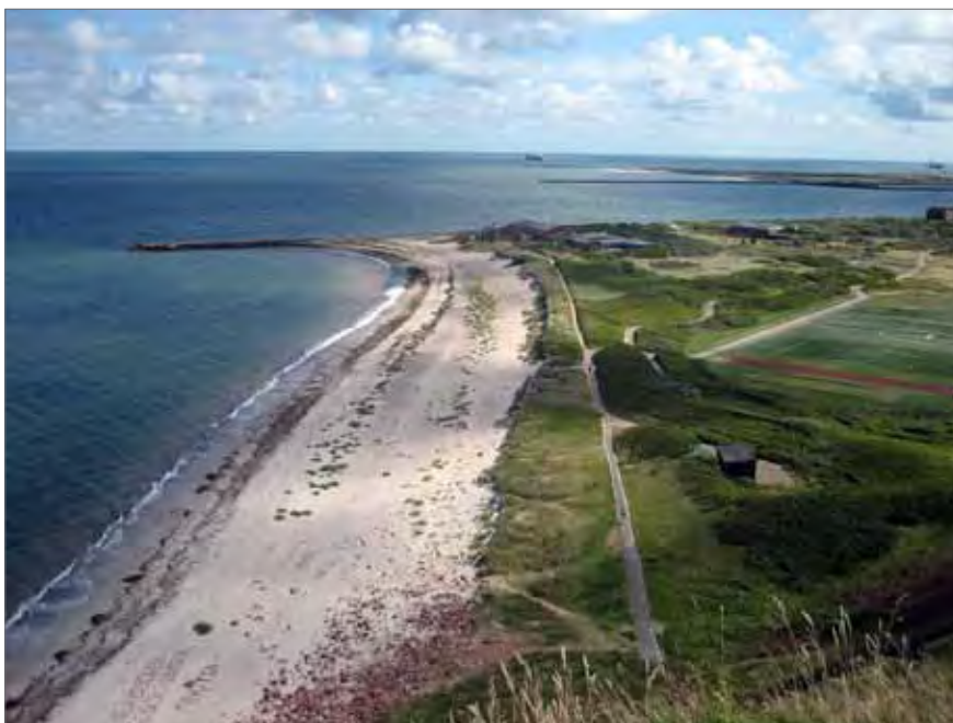
Abb. 112: Deichabschnitt am Nordoststrand mit vorgelagerten Sanddünen (eigene Aufnahme: 2009)
