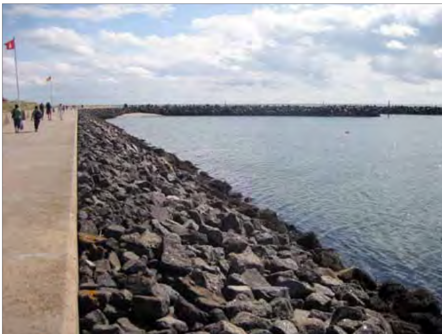
Abb. 118: Schüttsteine an der Südmole des Dünenhafens. Im Hintergrund die zusätzlichen Schüttdämme südlich der Hafeneinfahrt (eigene Aufnahme: 2009)
