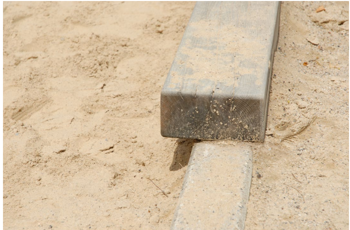
Abb. 10 Einfassung für Sandkästen aus Holzbalken mit gerundeten/gefaste Kanten (Beispiele)
