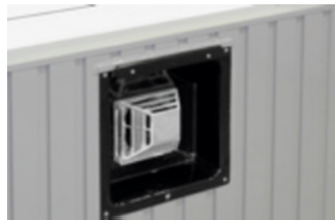
Abgasführung durch die Außenwand
