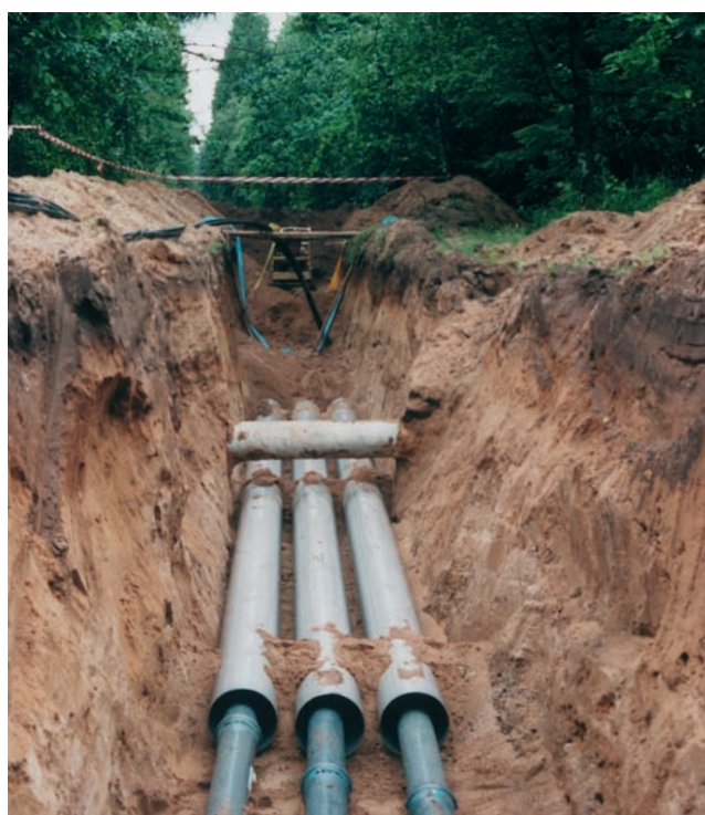
Abb. 25: Bau einer Rohrleitung für die öffentliche Wasserversorgung (Fa. Gebr. Lange, Halstenbek)
