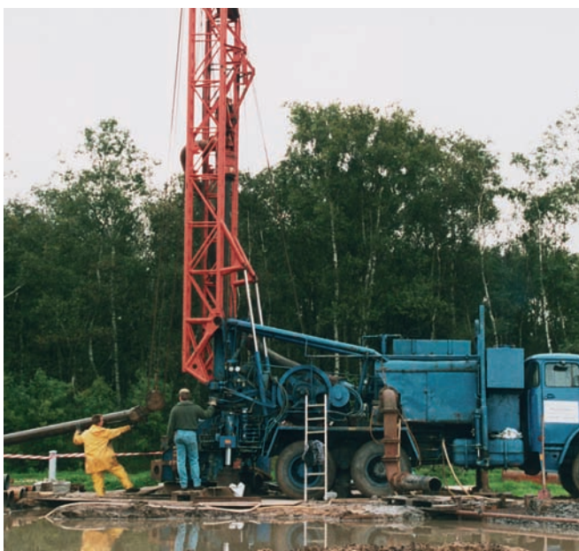
Abb. 17: Brunnenbohrung im Spülverfahren und Einsetzen von Rohren. (Fa. Gebr. Lange, Halstenbek)
