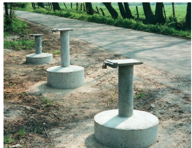
Abb. 7: Grundwassermessstellen-Gruppe westlich Hasloh. Die Messstellen sind in unterschiedlicher Tiefe verfiltrert (W. Scheer).
