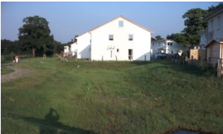
Eine ins Siedlungsgebiet integrierte Grabenversickerung ist häufig die bessere Alternative.
