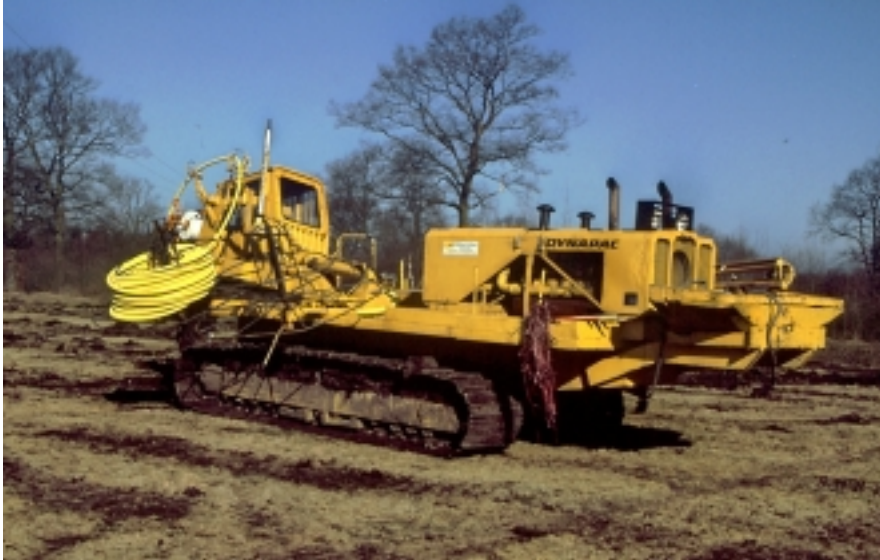
Intensivierung einer Landwirtschaftsfläche durch Verlegung von Drainage zur besseren Entwässerung.
