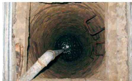
Eisenteile in Schachtbrunnen
