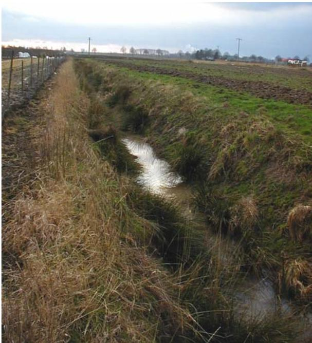
*Abbildung: Der bei dem Hochwasserereignis im Juni 2002 im SV Haselau-Haseldorf zur Entlastung angelegte „Notgraben“*
