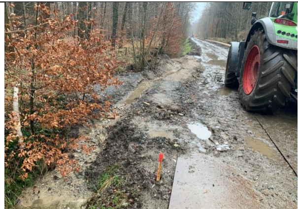
Abb. 10 In ein Gewässer abgeschwemmter Boden
