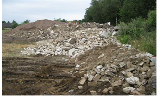
Abb. 8 Unsachgemäßer Umgang und Lagerung von Boden und Materialien
