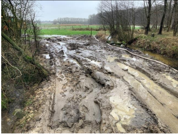
Abb. 1 : Verdichtung und Vermischung
