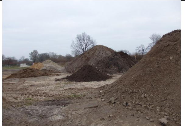
Abb.6 Trennung von Bodenmaterialien
